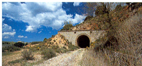
Túnel en las proximidades de Balazote, Albacete.
